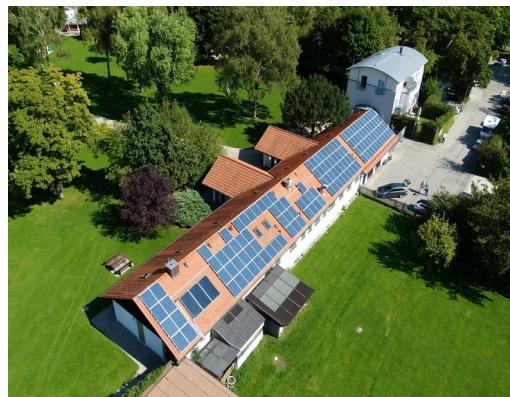
Photovoltaik-Anlage auf der Umkleide im Freibad
