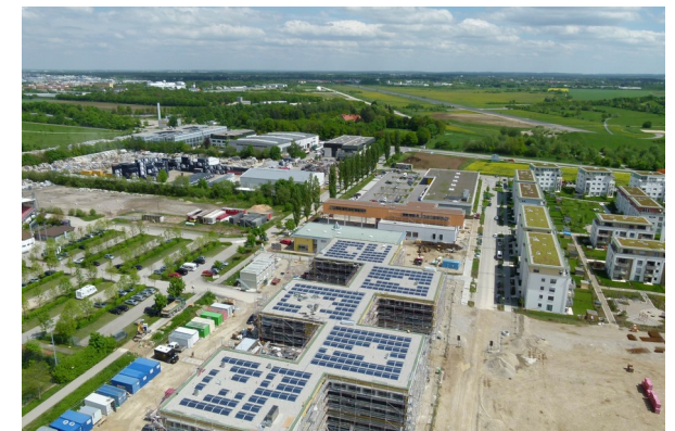
Photovoltaik-Anlage auf der Schule am Sportpark
